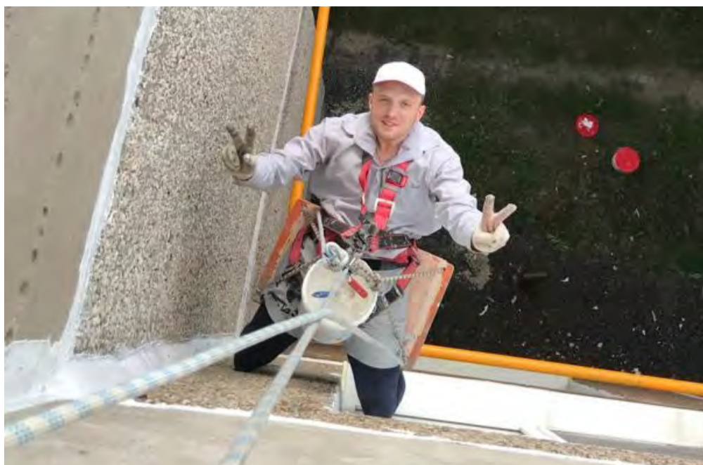
Заделка межпанельных швов в поселке Новоандросово
