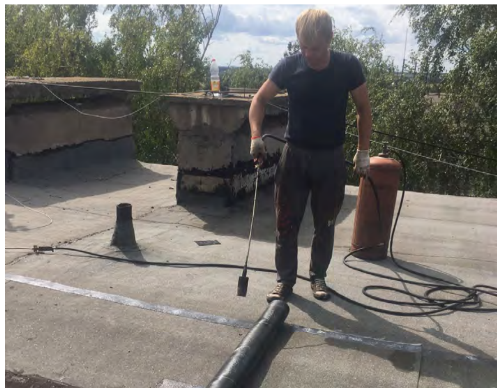
Подрядная организация под руководством Юрия Веретенникова занимается ремонтом кровли.
