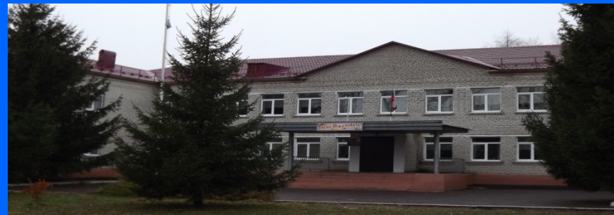
Ремонт кровли МКОУ «Троицкая СОШ»
