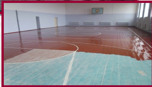
Капитальный ремонт спортивного зала МКОУ «Рышковская СОШ»
